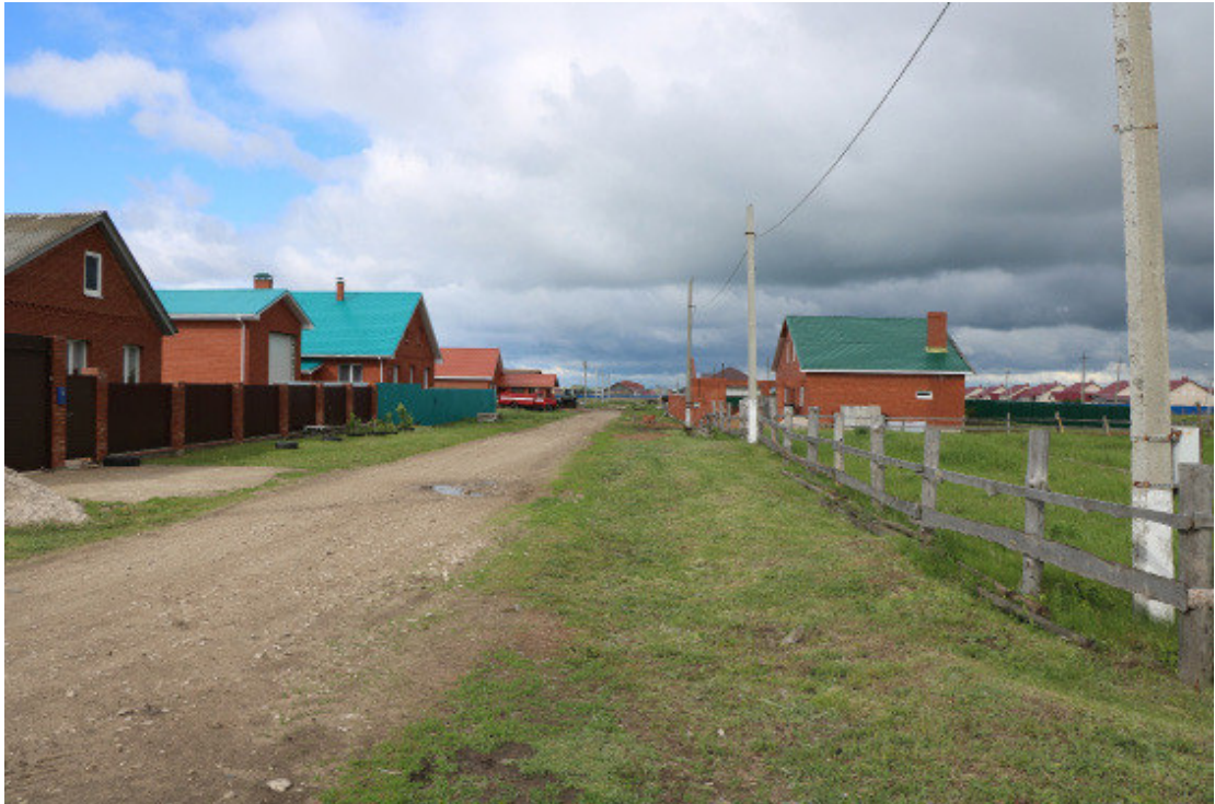
Илл. 5. Объект: «Техническое перевооружение сети газоснабжения Ставропольского района. Технологическое присоединение к газораспределительной сети 18-ти жилых домов, расположенных в с.п. Узюково, ул. Северная. Газопровод высокого давления 1 кат. от существующего г/да в/д d=100\text{мм} , проложенному от ГК-2 до ГРП-143 с. Узюково, ШГРП, газопровод низкого давления» на территории муниципального района Ставропольский Самарской области. Вид с юго-востока на участок обследования.
