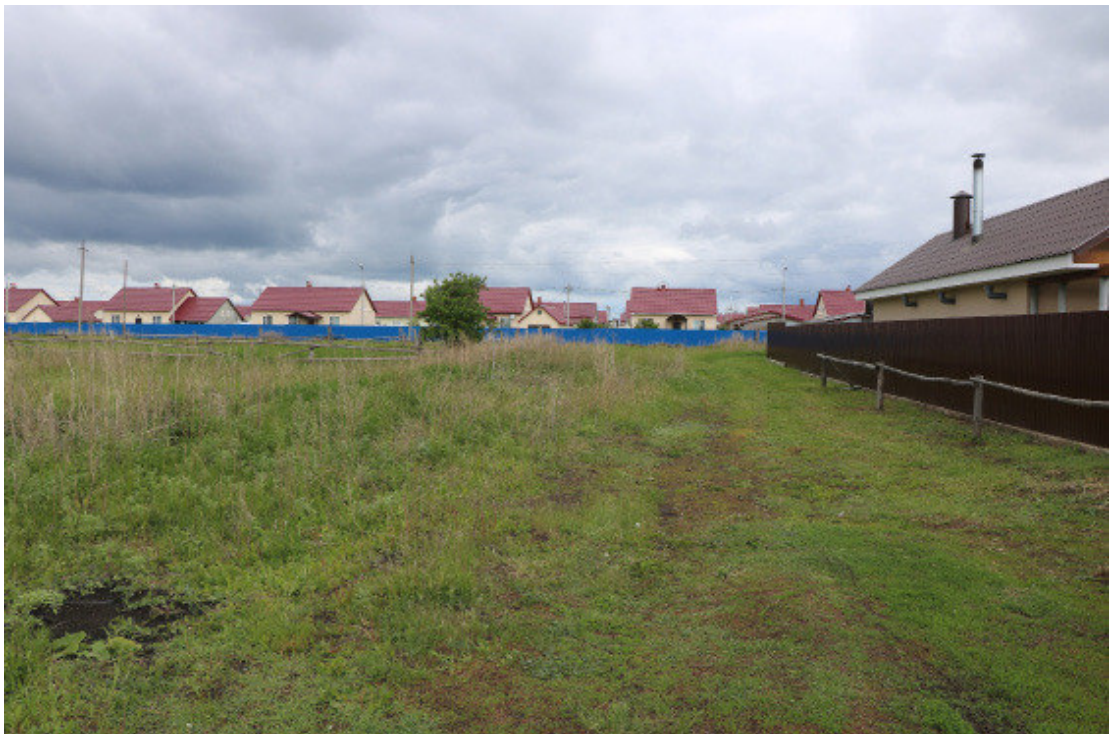
Илл. 6. Объект: «Техническое перевооружение сети газоснабжения Ставропольского района. Технологическое присоединение к газораспределительной сети 18-ти жилых домов, расположенных в с.п. Узюково, ул. Северная. Газопровод высокого давления 1 кат. от существующего г/да в/д d=100\text{мм} , проложенному от ГК-2 до ГРП-143 с. Узюково, ШГРП, газопровод низкого давления» на территории муниципального района Ставропольский Самарской области. Вид с юго-запада на участок обследования.
