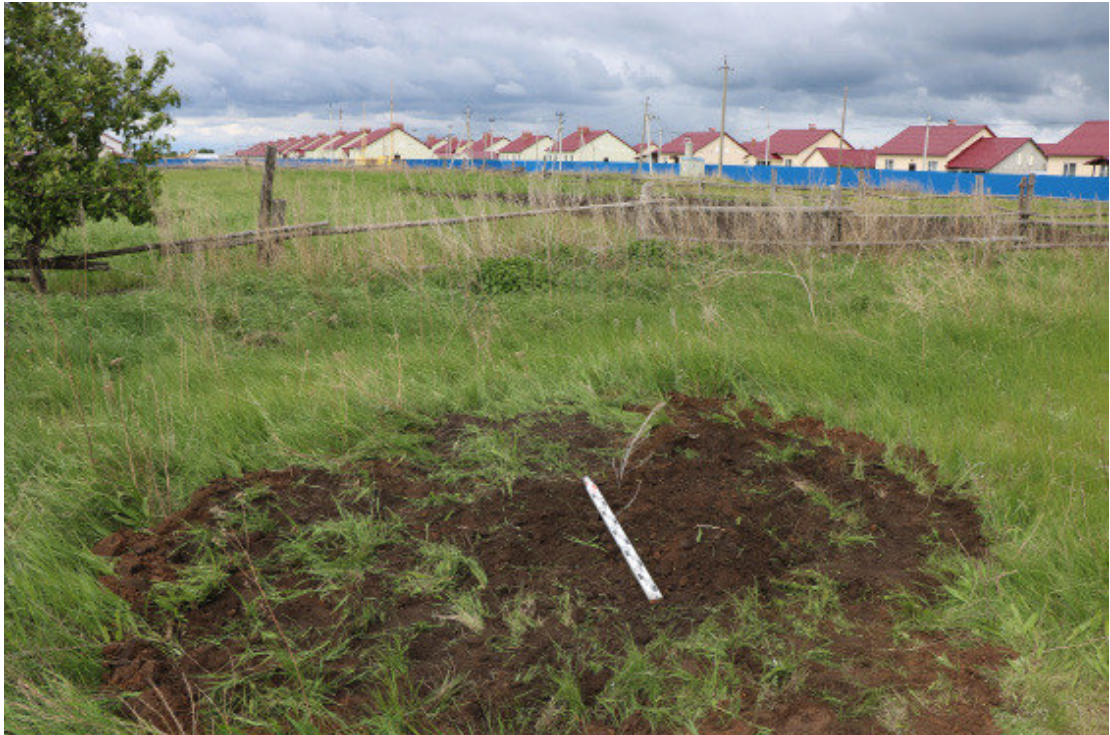
Илл. 9. Объект: «Техническое перевооружение сети газоснабжения Ставропольского района. Технологическое присоединение к газораспределительной сети 18-ти жилых домов, расположенных в с.п. Узюково, ул. Северная. Газопровод высокого давления 1 кат. от существующего г/да в/д d=100\text{мм} , проложенному от ГК-2 до ГРП-143 с. Узюково, ШГРП, газопровод низкого давления» на территории муниципального района Ставропольский Самарской области. Вид с востока на рекультивированный шурф 1.
